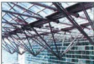
La struttura metallica di copertura, di grande valenza architettonica e caratterizzante l'intero complesso, è costituita da travi reticolari spaziali, di sviluppo in pianta di circa mt. 29 x 4,80 e poste ad interasse di mt.7,20, assimilabili ad ali aperte di gabbiano, con superfici di compluvio rivolte all'interno della copertura stessa.
