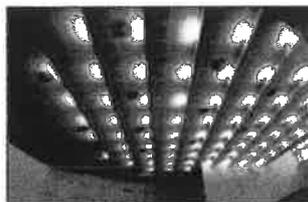
Il controsoffitto dell'Aula è stato realizzato con lastre forate in cartongesso fonoassorbenti disposte a scheid su superfici inclinate; sulle superfici verticali realizzate sempre in lastre di gesso sono incassati i corpi illuminanti.
